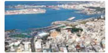
国際物流の拠点形成にむけて整備が進む那覇港
