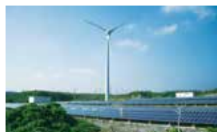
미야코섬의 풍력발전 시설
